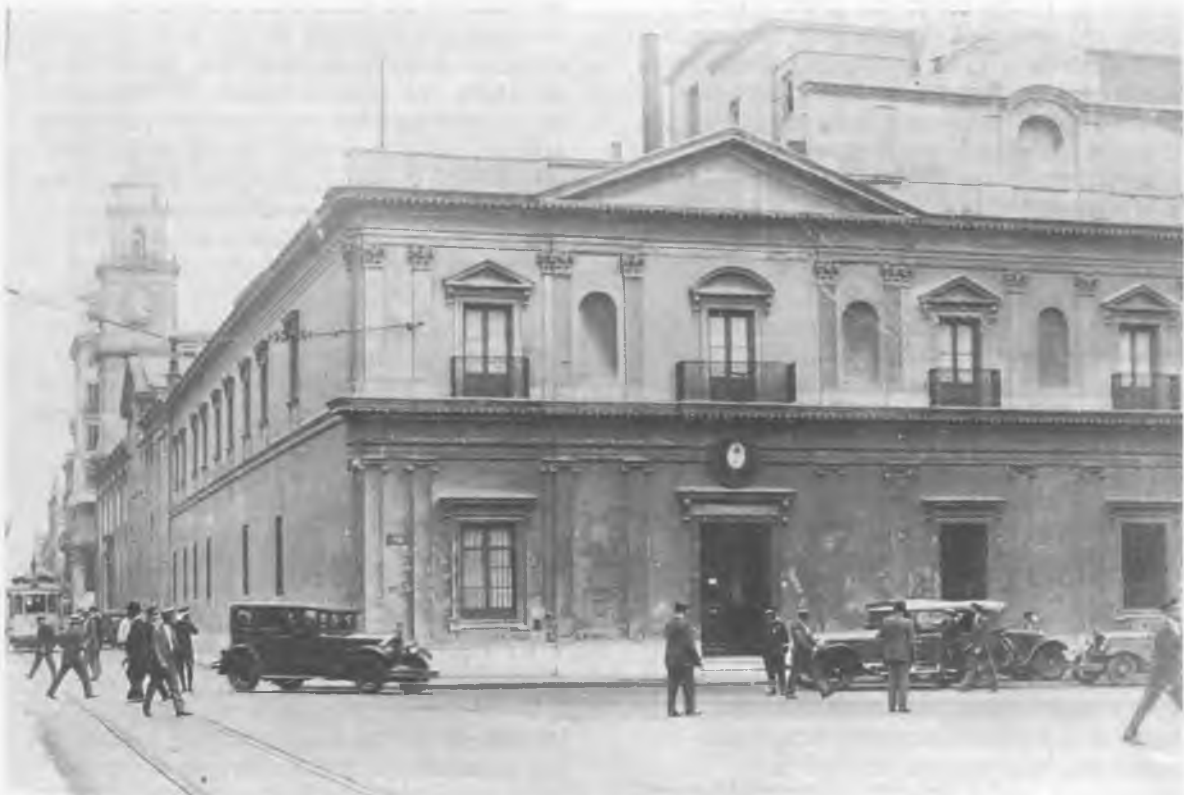
Fachada de la ex Procuraduría de Misiones, realizada hacia 1870, según fotografía del año 1930. (Archivo General de la Nación.)
