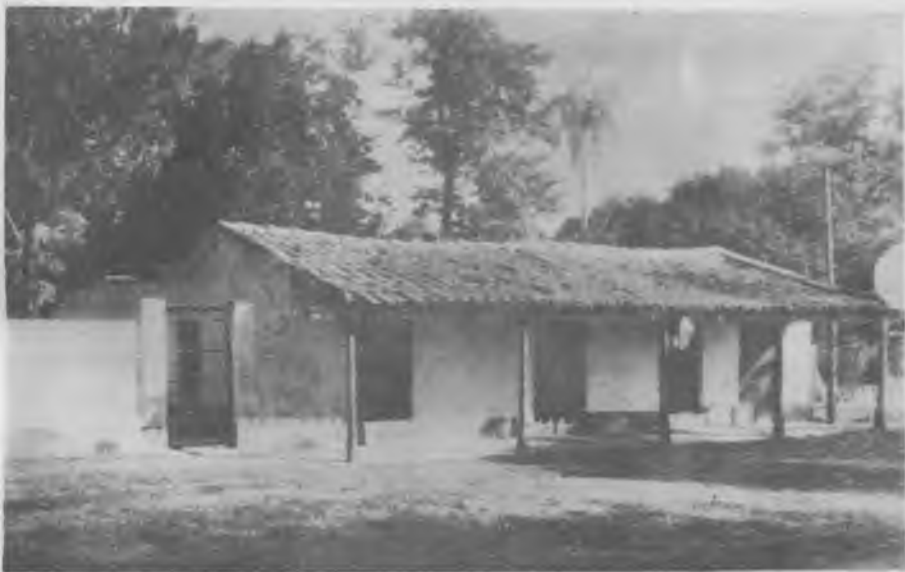
Construcción vecina a la Capilla
